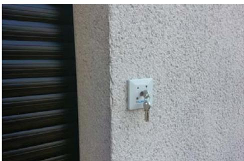
Cette porte existe en deux versions **électriques**, une première en RADIO avec télécommandes et armoire de gestion intérieure une seconde plus simple et aussi moins coûteuse FILAIRE avec contacteur clef extérieur et bouton poussoir intérieur.
