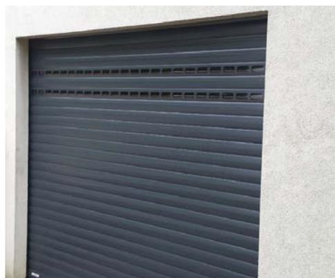
La porte de garage enroulable offre aussi la possibilité de positionner **des lames hublots pour la luminosité** intérieure du garage, cette porte est disponible avec **14 coloris** en standard.
